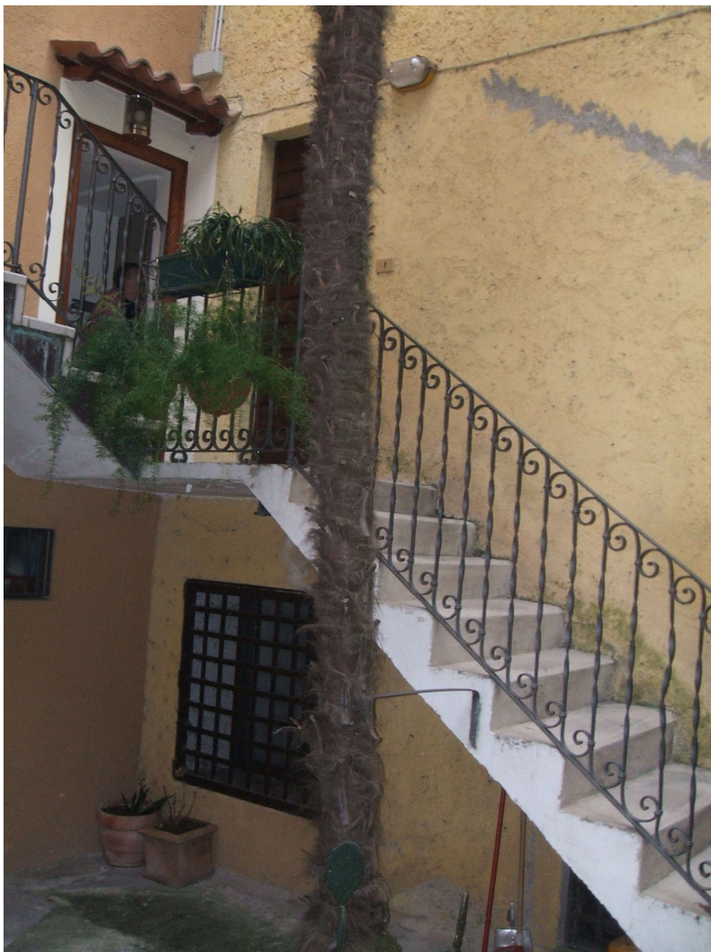
SCALA INTERNA ALLA CORTE
